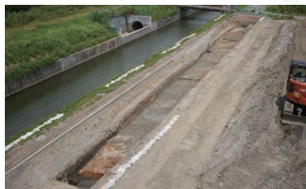
① 26Cb 区の全景 (南東から)
