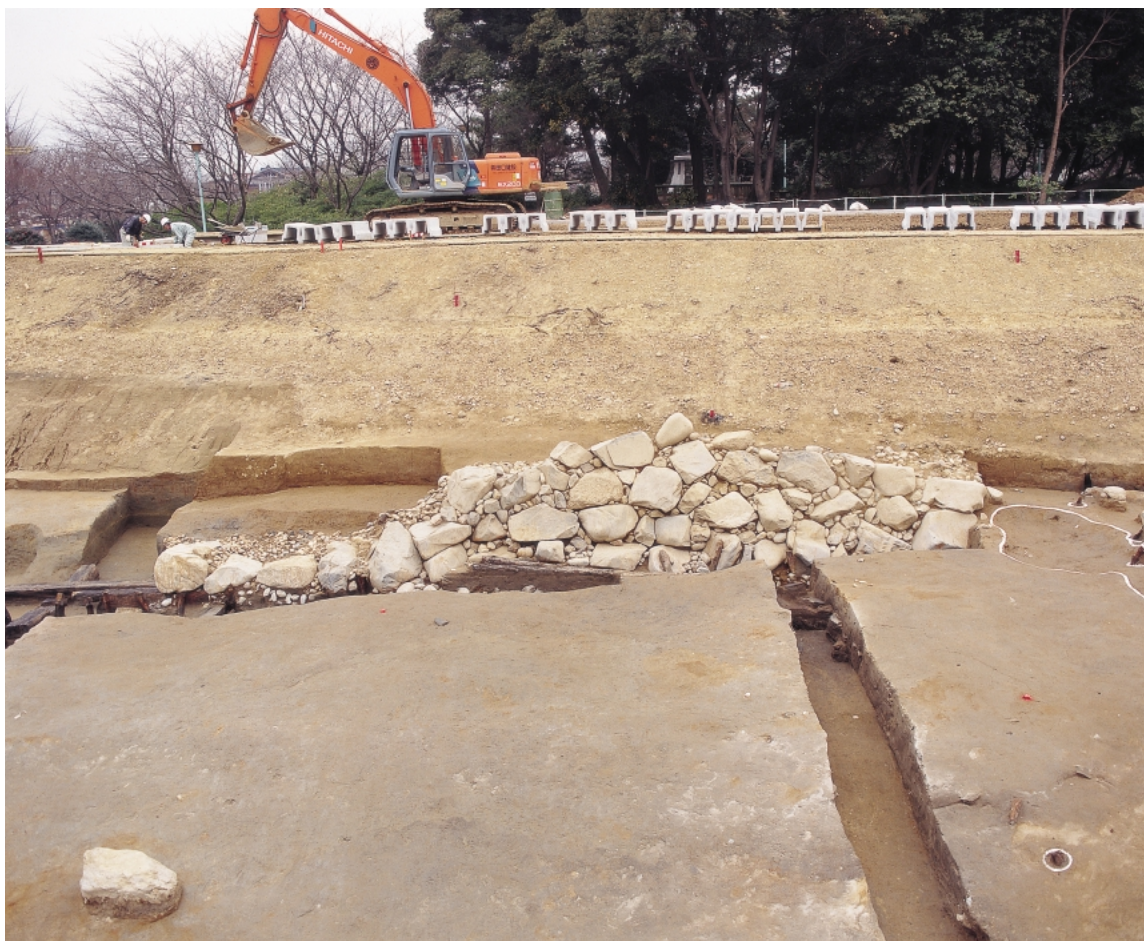
96区 SW01 (南東から)
