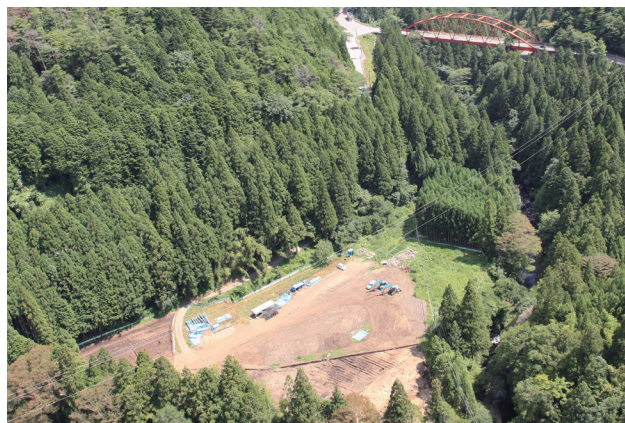
遺跡全景 _A 区・Ba 区調査時点 (北西から)
