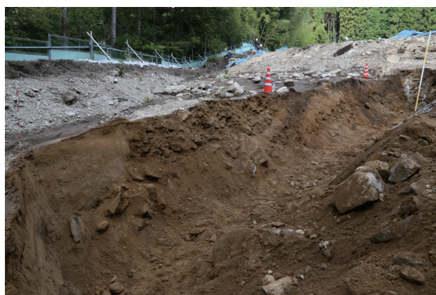
A 区 1 トレンチ北側深掘り断面 (南西から)
