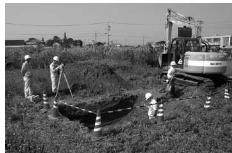
写真3 測量作業 (東地区TT02)
