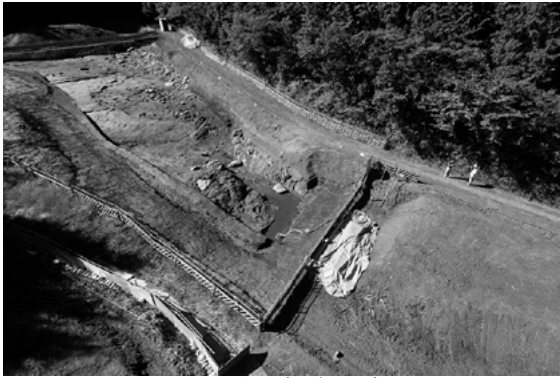
Bb区全景(北東より)
