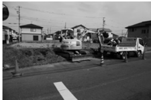
トレンチ掘削(12A区、西から)
