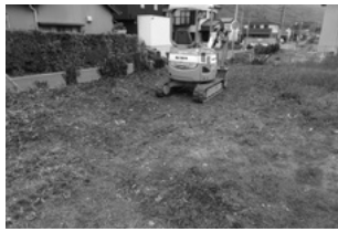
調査前風景(南から)
