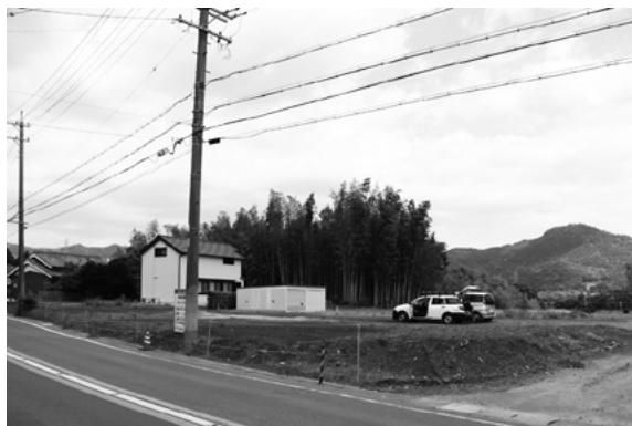
全景（南西から）
