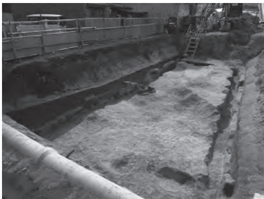
17B区下層 (064NR) 全景 (北東より)
