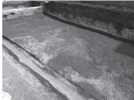
17B区遺構検出状況 (北西より)
