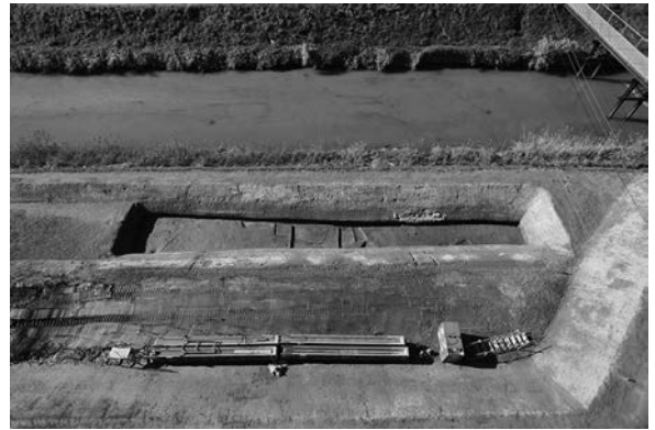
A区下面全景 (東より)
