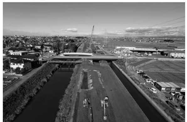
調査区遠景 (南より)
